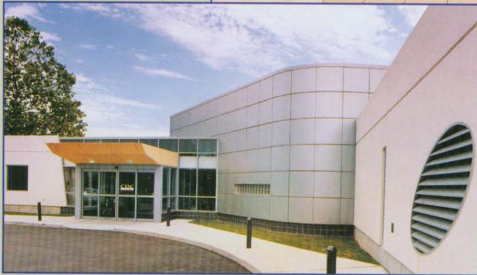
Van Kijk, Pace, Westlake Architects, Cleveland, OH
